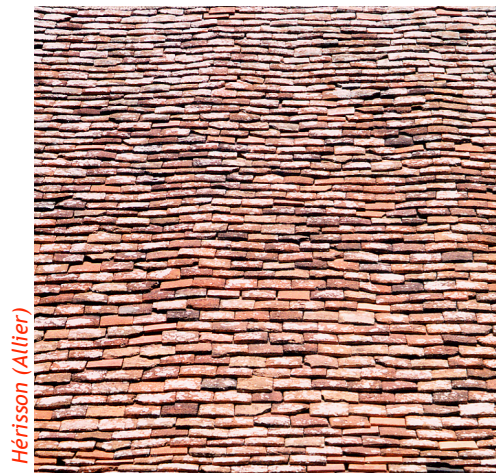
Tuile plate petit moule traditionnelle. Moulée et non filée, de teinte vieux rose, d'aspect mat, elle est très caractéristique du Bourbonnais.
