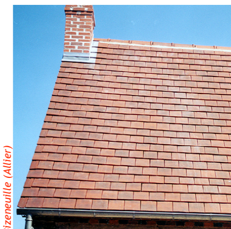
Tuile plate grand moule. Elle n'est utilisable que dans le secteur UP2, lorsque les circonstances l'autorisent. Sa teinte devra faire l'objet d'une concertation, car certaines patines ne sont pas adaptées.
