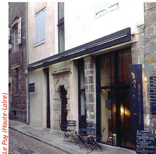
Une intervention très simple, sur un immeuble historique. Noter qu'il n'y a qu'un seul matériau utilisé, le métal teinté en noir.
