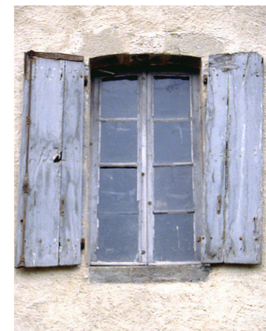
Menuiserie ancienne (fin XVIIIe ou première moitié du XIXe siècle) dont les principes de composition sont à conserver: la découpe des vitrages constitue un rythme secondaire de l'architecture et réticule la façade.
