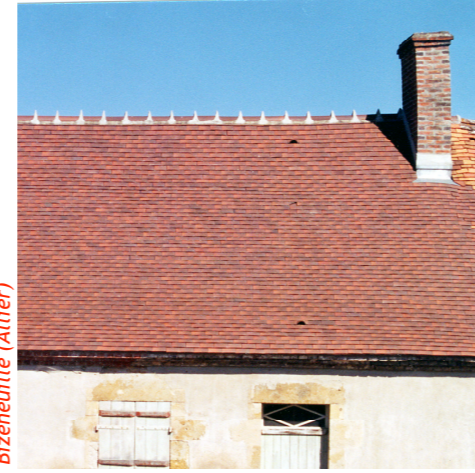
Tuile plate petit moule moderne. Son aspect est plus régulier que la tuile ancienne, mais se prête à tous les détails d'exécution traditionnels. Il faut 54 unités pour couvrir 1 mètre carré. Par contre sa couleur varie selon les provenances (naturelle, ou vieillie).
