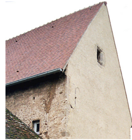
Tuile plate petit moule moderne. Son aspect est plus régulier que la tuile ancienne, mais se prête à tous les détails d'exécution traditionnels. Il faut 54 unités pour couvrir 1 mètre carré. Par contre sa couleur varie selon les provenances (naturelle, ou vieillie).
