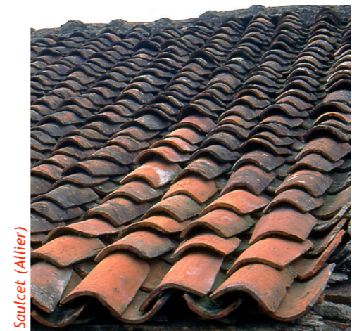
Tuile creuse. Elle a pratiquement disparu du site mais il n'est pas exclu qu'il puisse être nécessaire d'en utiliser sur des éléments secondaires.
