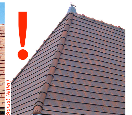
Tuile plate grand moule. Elle n'est utilisable que dans le secteur UP2, lorsque les circonstances l'autorisent. Sa teinte devra faire l'objet d'une concertation, car certaines patines ne sont pas adaptées.
