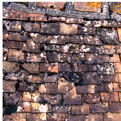
Tuile plate petit moule traditionnelle. Moulée et non filée, de teinte vieux rose, d'aspect mat, elle est très caractéristique du Bourbonnais.
