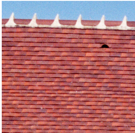
Faîtage "à crêtes et embarrures"
